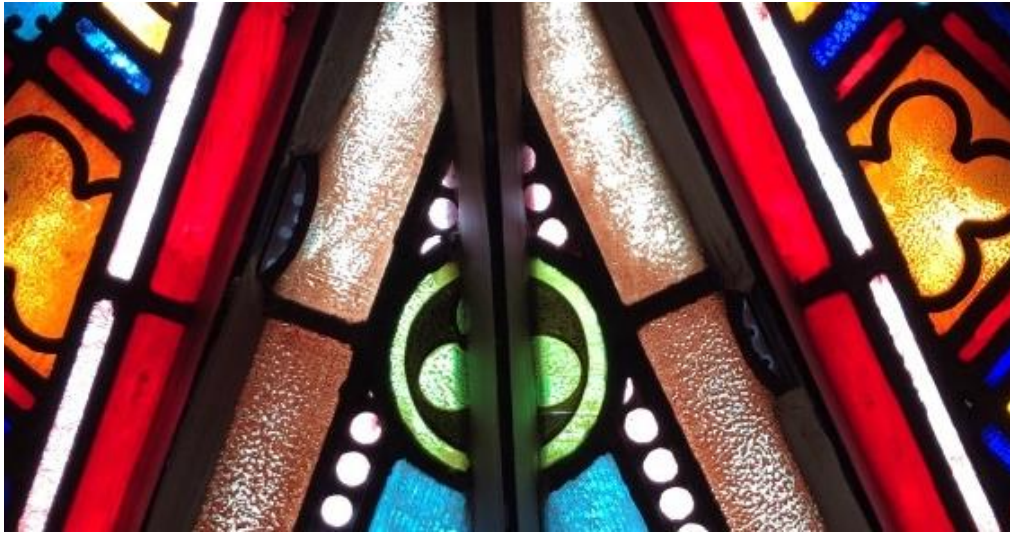
Fig. 3.- Imagen final de los paños del rosetón colocados con su sistema de entrada y salida de aire a la cámara de aire (Fotografía: María Paula Farina Ruiz).
