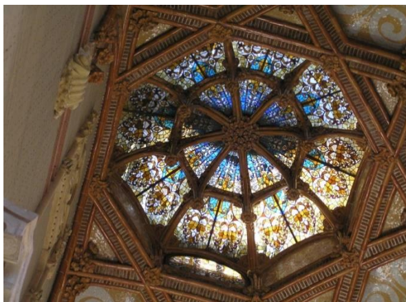
Fig. 5.- Claraboya del pabellón administrativo del Hospital de la Santa Creu i Sant Pau , Barcelona. Foto: Núria Gil
