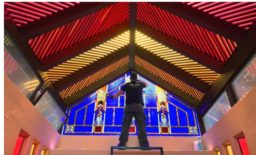
Instalando dos vidrieras idénticas en un panteón de estilo Frank Lloyd Wright
